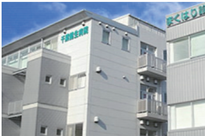
< 千葉健生病院 (外観) >
